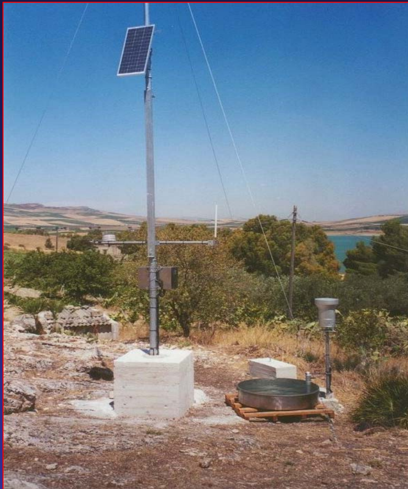
Diga Arancio – Stazione PTIREA: Pluviometro Termometro Idrometro (piezometro) Piranometro Evaporimetro Anemometro
